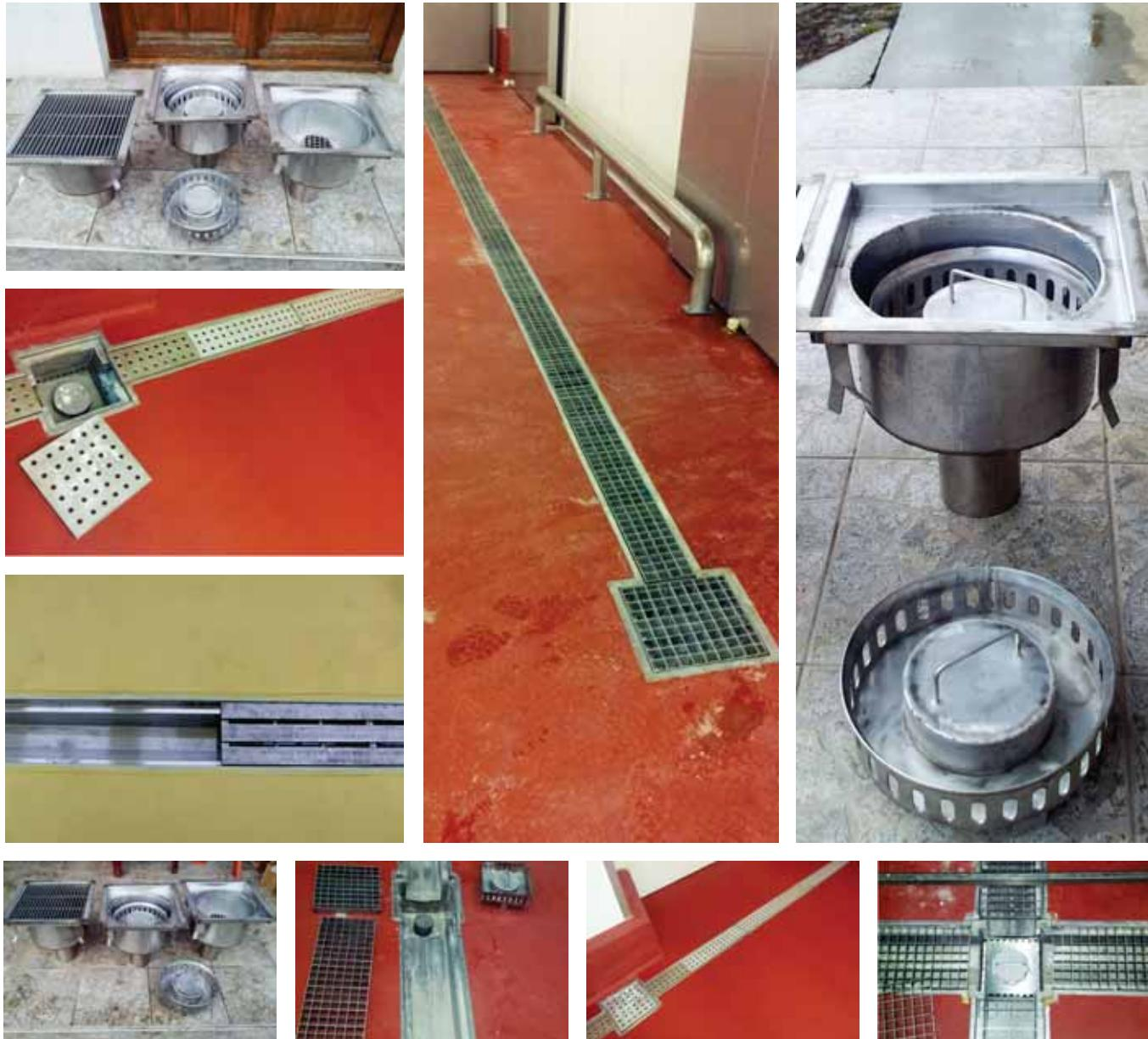
Scarichi e canali per scarico delle acque sporche.
