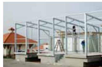
Capannoni a montaggio vengono costruiti per produzione, come magazzini e uffici e per altri bisogni. Possono essere rivestiti dai pannelli sandwich o dalle lamiere trapezoidali a seconda delle esigenze degli investitori.
