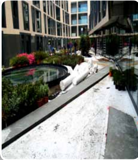
Ugradnja betonskih staza iznad sloja geotekstila položenog na drenažne ćelije
