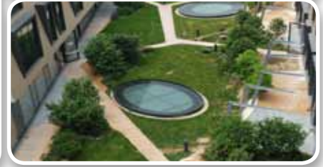
Ugradnja hodnih staza, slojeva zemlje i vegetacije iznad sloja geotekstila položenog na drenažne ćelije - omogućuje "disanje" sustava!
