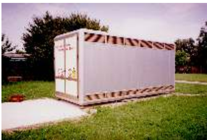
skladište zapaljivih materija inflammable fluid warehouse
