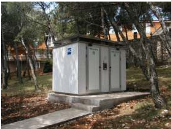
Samo iste a sanitarija sa ventiliranom fasadom postavljena na plaži, parku ili urbanim centrima. Self-cleaning toilet with ventilated facade used on beach
